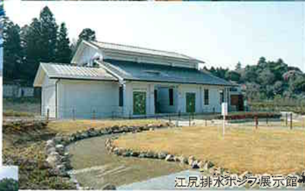
江尻排水ポンプ展示館
