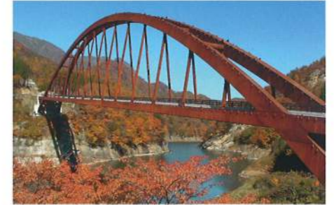
奥裾花ダム ダム湖に架かる奥裾花大橋は林道に架かる中路式ローゼ橋としては国内最長。茶色のアーチ橋が新緑、紅葉とあまって湖面に映えて美しい。
